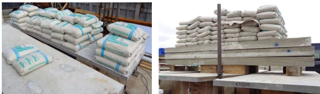
Obr. 7 Vlevo simulace charakteristické hodnoty zatížení chodci - 5 kN/m 2 pomocí pytlů s pískem, vpravo snaha o dosažení únosnosti mostovky – zatížení odpovídá cca 23 kN/m 2
