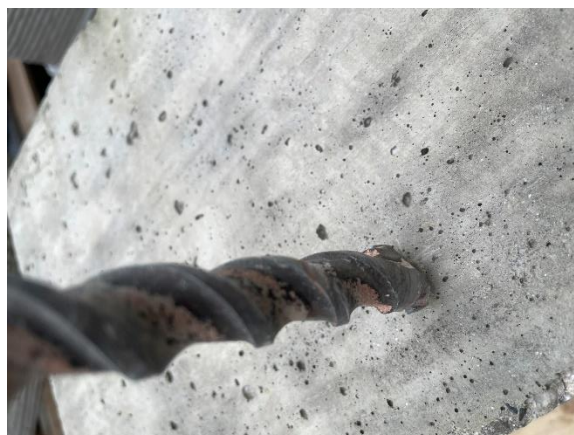
Vyvtání otvoru o průměru 20 mm
