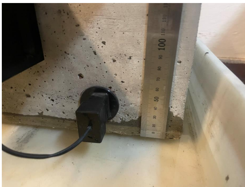
Ponoření objektu do vody pro zjištění stavu vlhkosti při vzlínání vody
